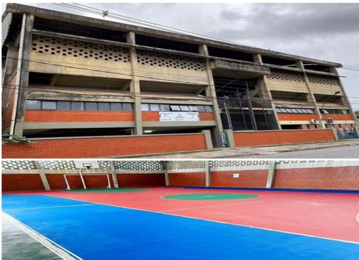
Figura 98 - Equipamento CSU Frente (acima), quadra CSU reformada (abaixo) – dezembro de 2020
