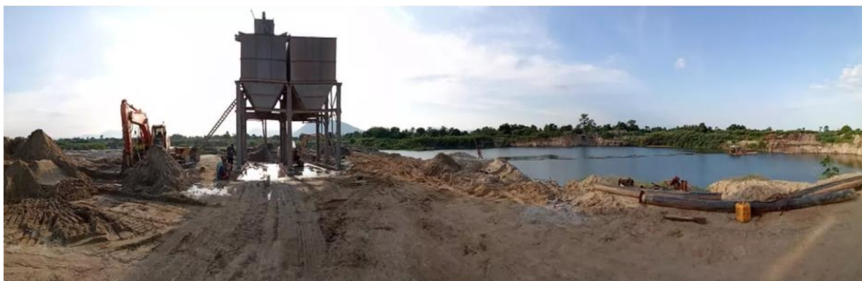
Figura 82 - Extração de areia e cava molhada no subterritório de Piranema Fonte: Coelho (2019).
