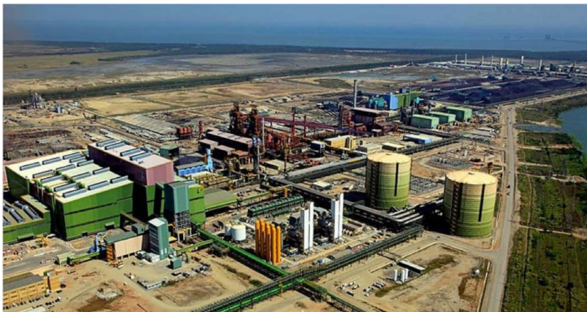
Figura 13 - Vista aérea Techint/Ternium Brasil – Zona Industrial de Santa Cruz/RJ Fonte: https://www.brasildefato.com.br
