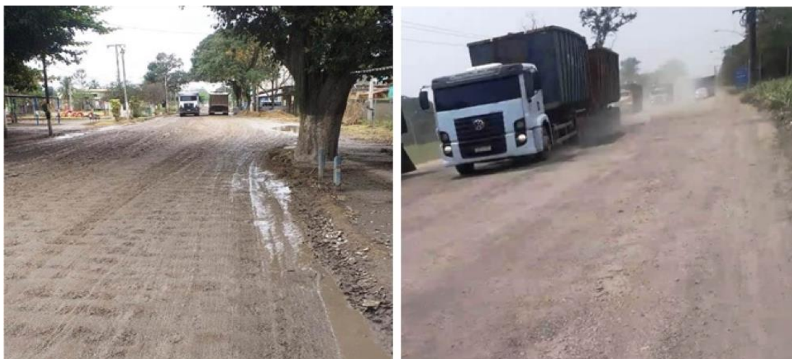
Figura 91 - Falta de pavimentação asfáltica, intensa movimentação de caminhões, poeira e barulho constante – subterritórios de Piranema IV (esquerda) e Rio da Guarda (V) (direita)
