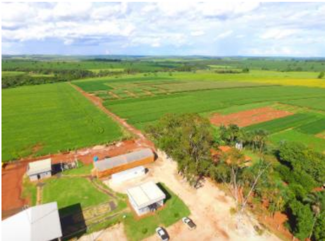
Figura 4 - Centro de Inovação e Tecnologia – CIT/GAPES - Fonte: GAPES, 2021. 3
