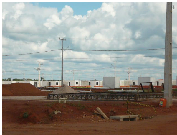
Figura 43: Casas pré-moldadas em construção. Vila da Sadia, Lucas do Rio Verde. (Foto: Betty Rocha, 2008).
