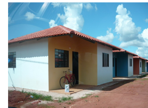
Figura 46: Casas pré-moldadas. Vila da Sadia, Lucas do Rio Verde. (Foto: Betty Rocha, 2008).
