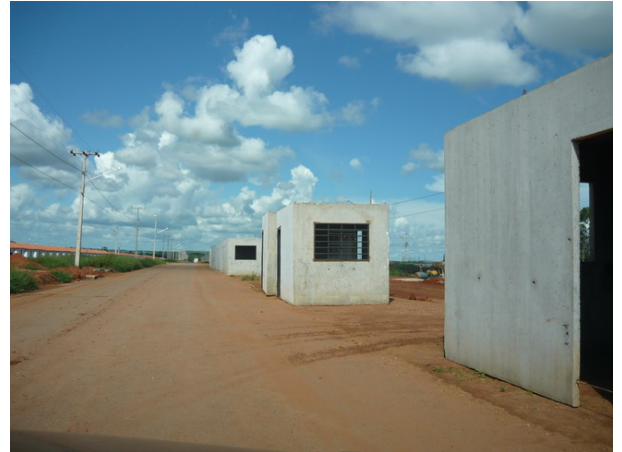
Figura 42: Blocos da casa pré-moldada. Vila da Sadia, Lucas do Rio Verde. (Foto: Betty Rocha, 2008).
