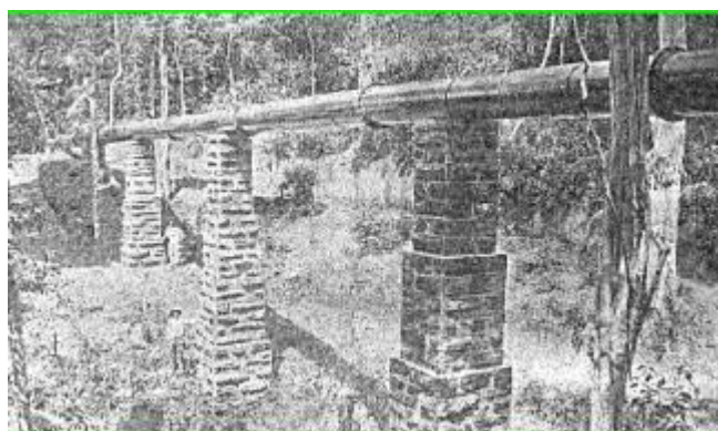
Figura I-5: Aqueduto interligando açude da Cachoeira de São Jorge a fábrica Companhia Têxtil Brasil industrial, em 1892. Fonte: Bohrer (2004).
