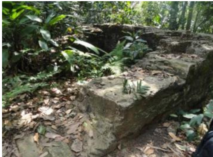
Figura I-11: Ruínas da estrutura que distribuía água para o açude da Cascata e para a fábrica.
