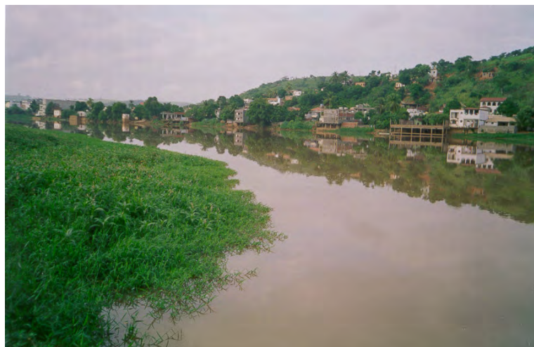
Figura 46. Rio Muriaé no município de Italva-RJ. Observar o detalhe das margens desprotegidas e ocupadas por área urbana.
