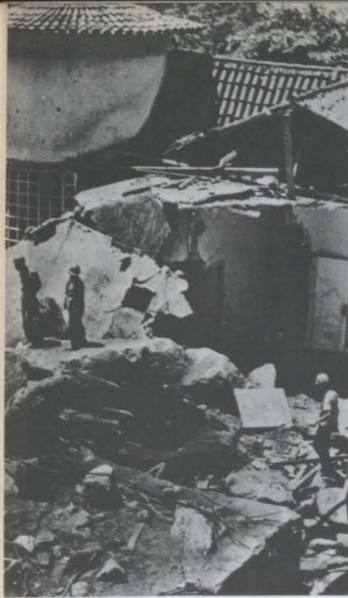
Clínica Santa Genoveva no Rio: só ruínas
