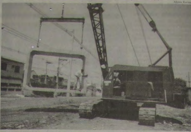
Vista parcial das obras de macrodrenagem que estão sendo realizadas em Mesquita.
