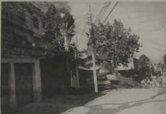
A Rua Pau Brasil, uma das principais da Vila São Teodoro, encontra-se em estado lastimável.
