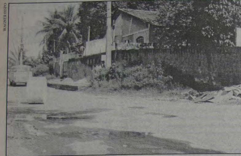
Dos vários problemas apontados pelos moradores da Rua Leonor, em Banco de Areia, a falta de iluminação é o maior deles.
