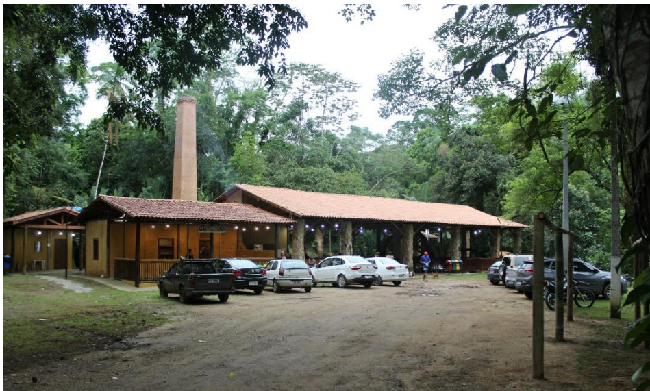
Figura 6. A estrutura da Casa de Farinha localizada à direita da foto e da Casa de Artesanato, localizada à esquerda. (Fonte: Autora).
