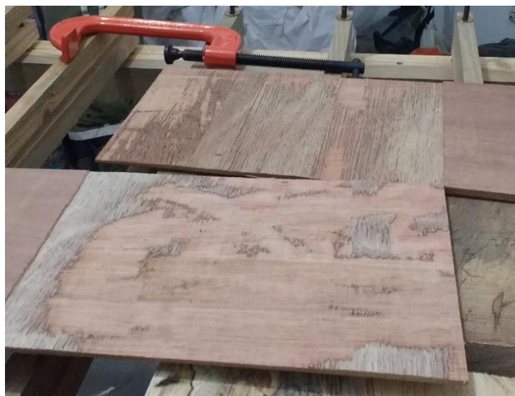
Figura 16. Corte do compensado para colagem da peça da longarina.
