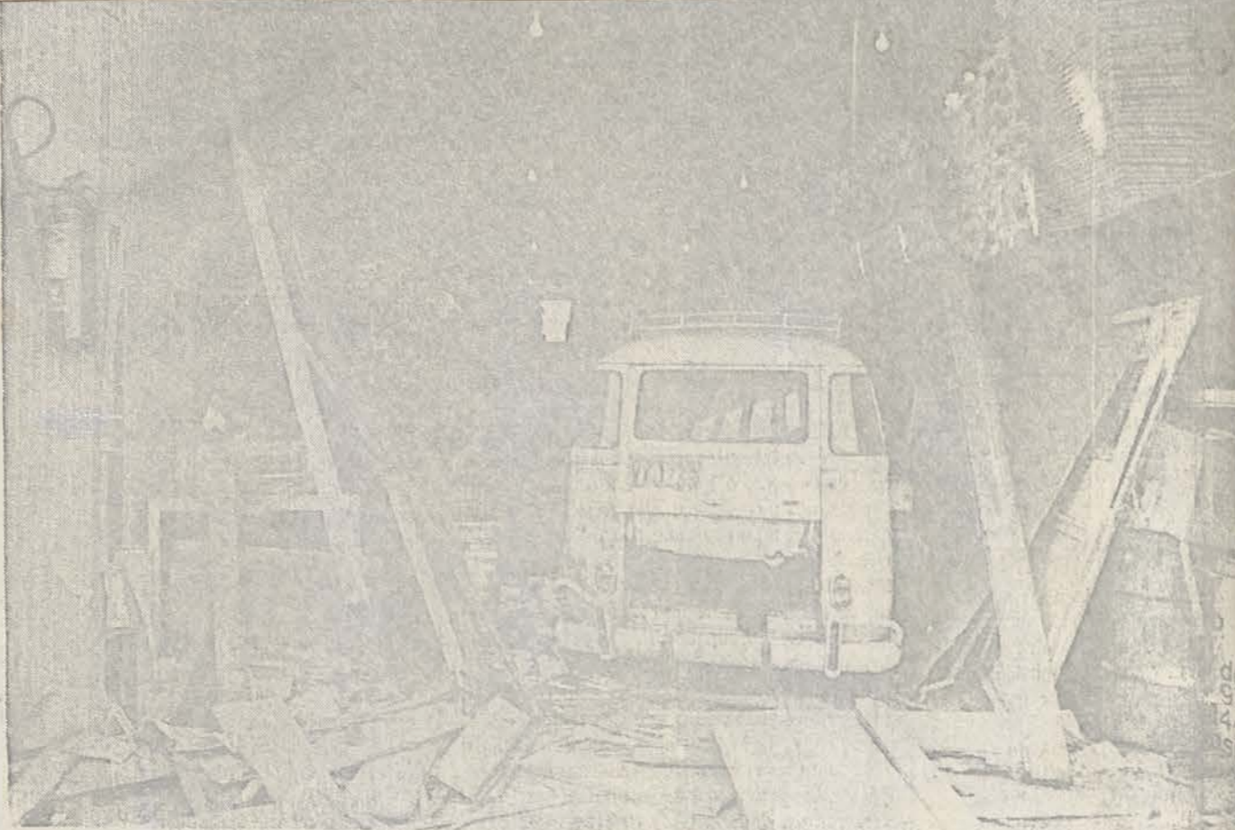
O portão de madeira desapareceu na explosão. Dentro, a destruição atingiu até a parede, que rachou.
