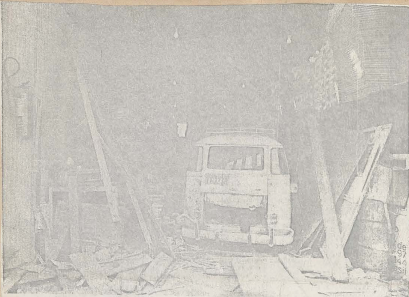
O portão de madeira desapareceu na explosão. Dentro, a destruição atingiu até a parede, que rachou
