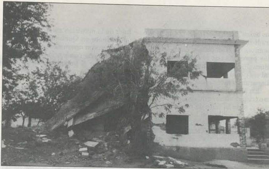
Mangunde, donde Dhlakama nació. Del viejo colegio, sólo restan escombros
