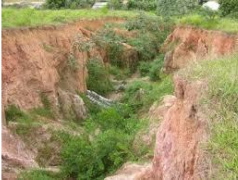
Figura 3: Ravina em processo avançado de degradação.
