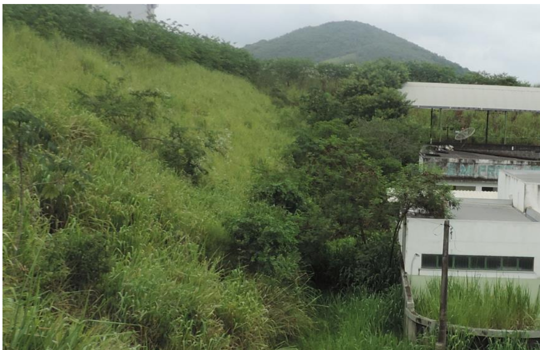
Figura 16: Talude do tratamento com medidas G3. Obtida em agosto de 2016.
