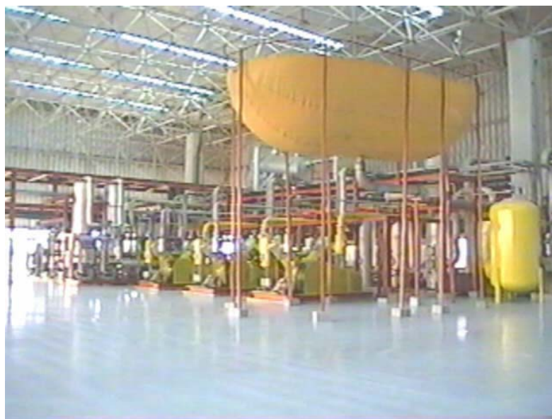
Figura 6: Ilustração do compartimento onde o CO 2 é inicialmente armazenado. (Balão)
