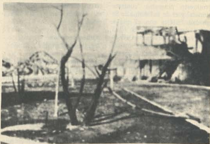
Depósitos de combustibles destruidos por la CIA en el puerto de Corinto
