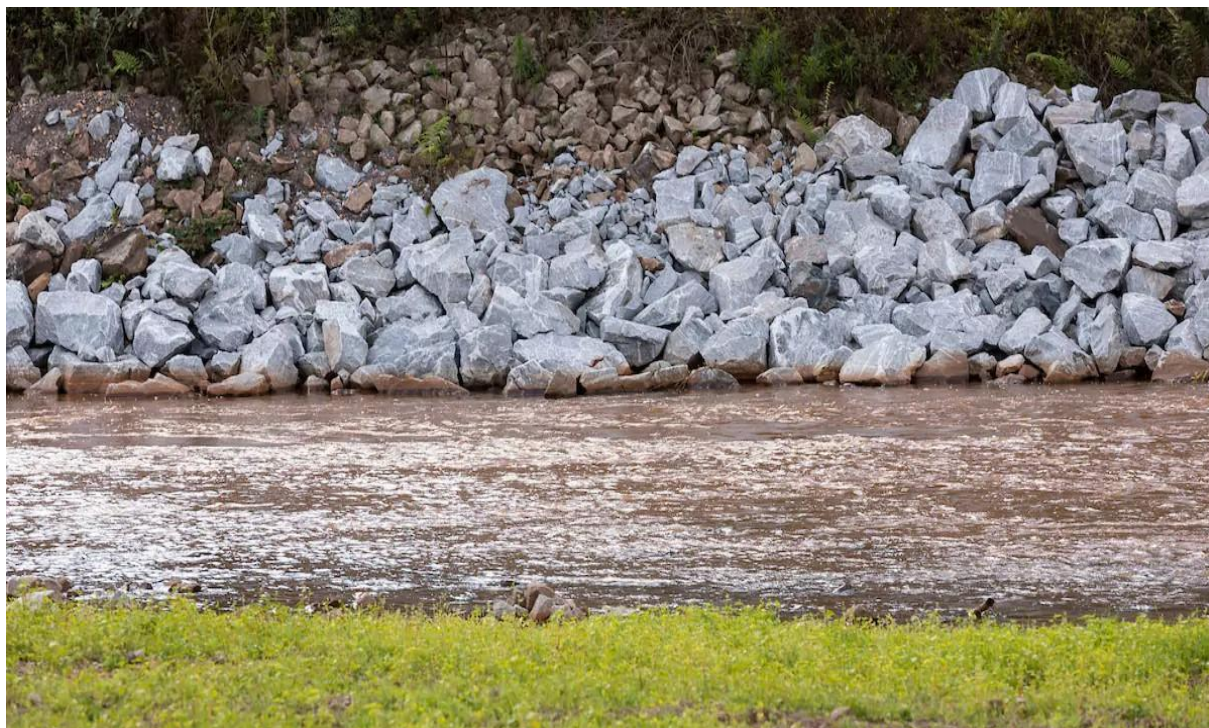
Figura 13 — Técnica de bioengenharia: enrocamentos
