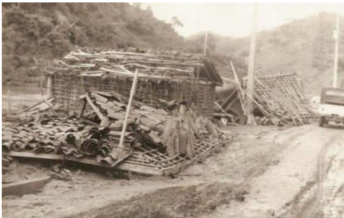
Figura 26 — Casas destruídas pela enchente de 79 (Volta da Capela)
