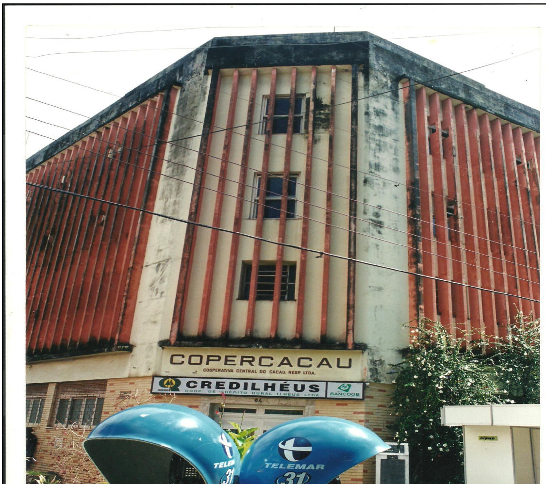
Figura 6: Prédio-sede da Cooperativa Central do Cacau Ltda., em Ilhéus-BA
