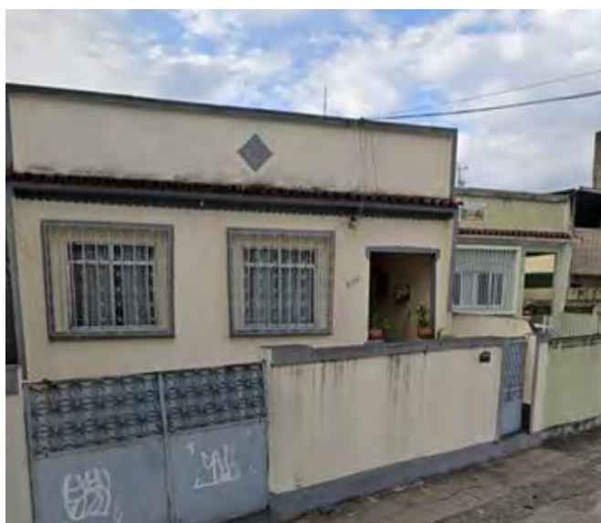
Figura 41. Estrada do Engenho da Pedra 840
