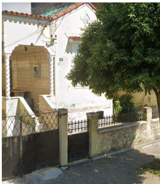
Figura 22. Tipologia de construção comum no bairro de Ramos.
