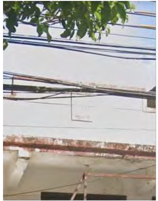
Figura 43. Rua Sargento Ferreira, nº 26 Fonte: Fotografia da autora
