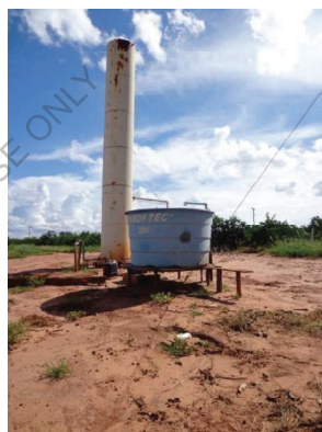
Figura 7: Abastecimento d'água por poço artesiano
