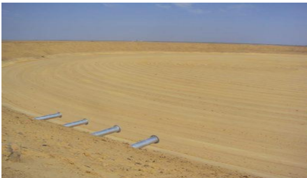
Figura 25 – Piscinão para armazenamento de água da fazenda Sudotex. Correntina (2016)
