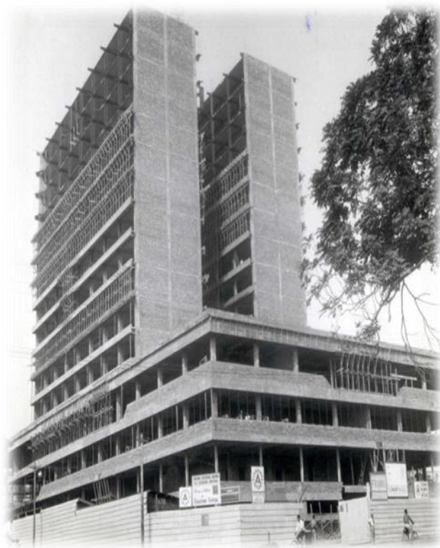
Figura 11 – Construção do Escritório Central
