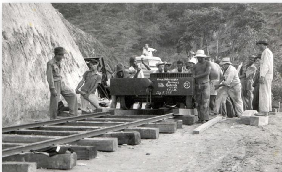
Figura 7 - Construção de linha férrea, ainda hoje funciona no transporte dentro da CSN. Uma das primeiras atividades que o nosso primeiro interlocutor realizou; “soca de linha”.
