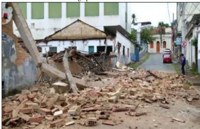
Figura 38: Desabamento de um galpão centenário no Centro histórico de Resende.
