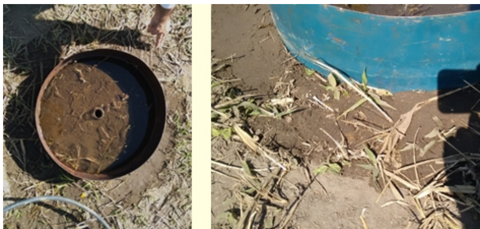
Figura 37 – a) Coroa de umidade; b) Visão detalhada da Coroa de umidade
