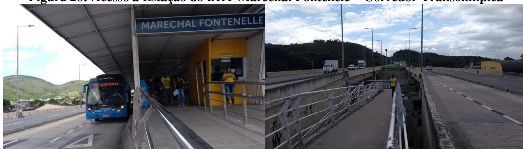
Figura 26: Acesso à Estação do BRT Marechal Fontenele – Corredor Transolímpica
