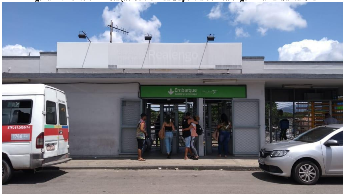
Figura 24: Ponto 01 – Estação de trem da Supervia de Realengo – Ramal Santa Cruz
