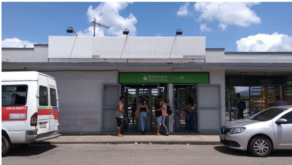
Rua Dr Lessa: Ponto 01 – Estação de trem da Supervia de Realengo – Ramal Santa Cruz
