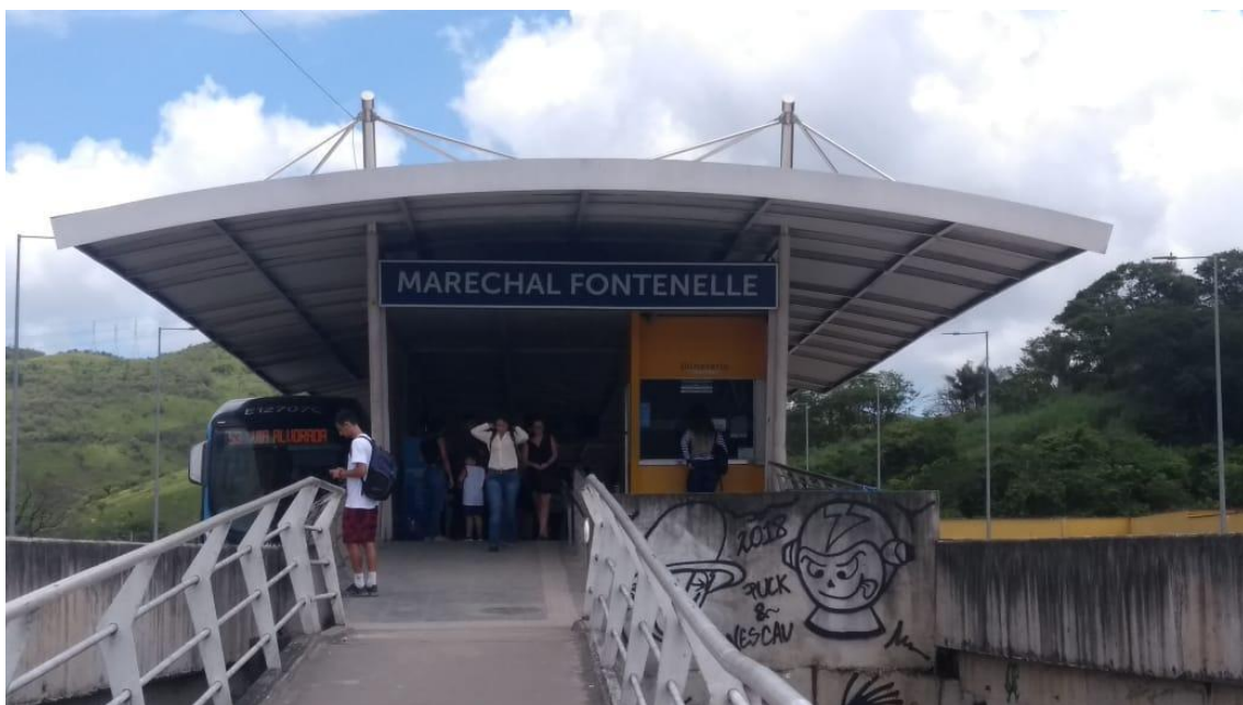
Estação do BRT Marechal Fontenele – Corredor Transolímpica
