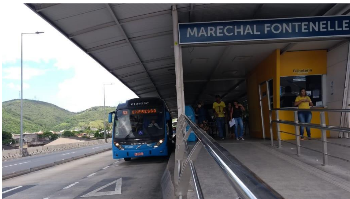
Estação do BRT Marechal Fontenele – Corredor Transolímpica
