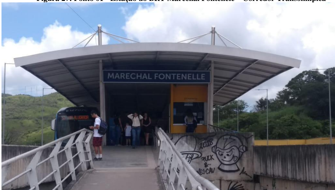
Figura 27: Ponto 01 - Estação do BRT Marechal Fontenele – Corredor Transolímpica
