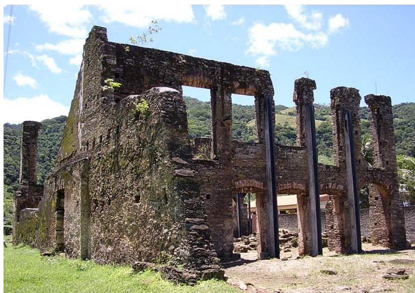
Figura 7. Ruínas na Estrada de São João Marcos (RJ-149) - Serra do Piloto. Fonte: Prefeitura Municipal de Mangaratiba. 21
