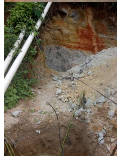
Corte na encosta /rocha para futura construção
