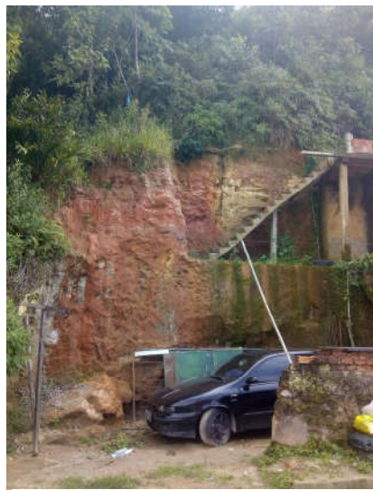
Casa construída no corte do talude
