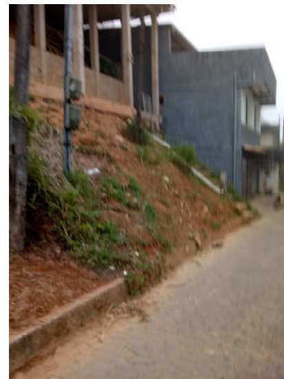
Casa construída na encosta com cano para despejo de águas servidas
