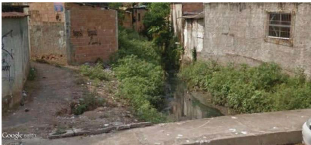
Figura 17: Casas construídas no leito do rio (Canal Maxambomba - Nova Iguaçu)
