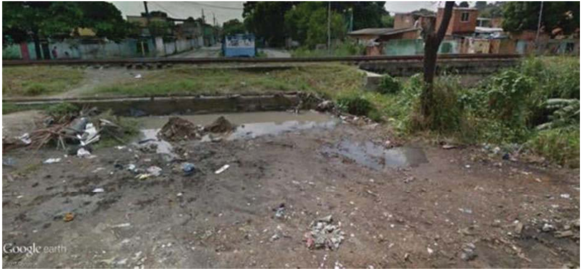
Figura 42: Entulho e vala de esgoto depositando no canal Maxambomba Fonte: Google Earth (2017)
