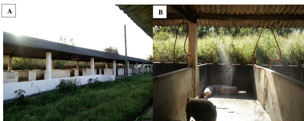
Figura 5. Setor da Suinocultura do Instituto de Zootecnia da UFRRJ (A) e detalhe da baia abrigando os suínos na fase de engorda, manejados sob o sistema confinado (B).
