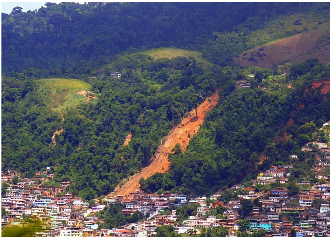
Imagem 1 – Vista do Morro da Carioca, no centro de Angra - Deslizamento ocorrido na noite do dia 31/12/2009. Fonte: https://pt.wikipedia.org/wiki/Ficheiro:Angra_dos_Reis-Morro_da_Carioca-2010-01-04.jpg Foto: Roosevelt Pinheiro/ABr - Acessado em 15/07/2018.
