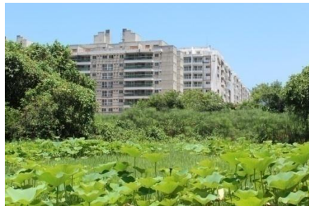
Figura 11: Prédios do bairro Pontal Oceânico, construído em área alagada
