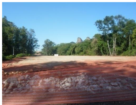
Figura 5: Construção da Via Transolímpica (Curicica)
