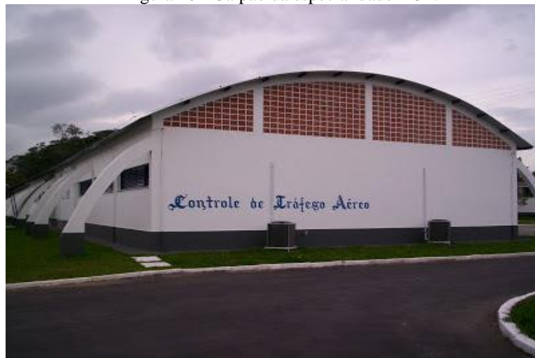
Figura 20 - Galpão da especialidade BCT.
