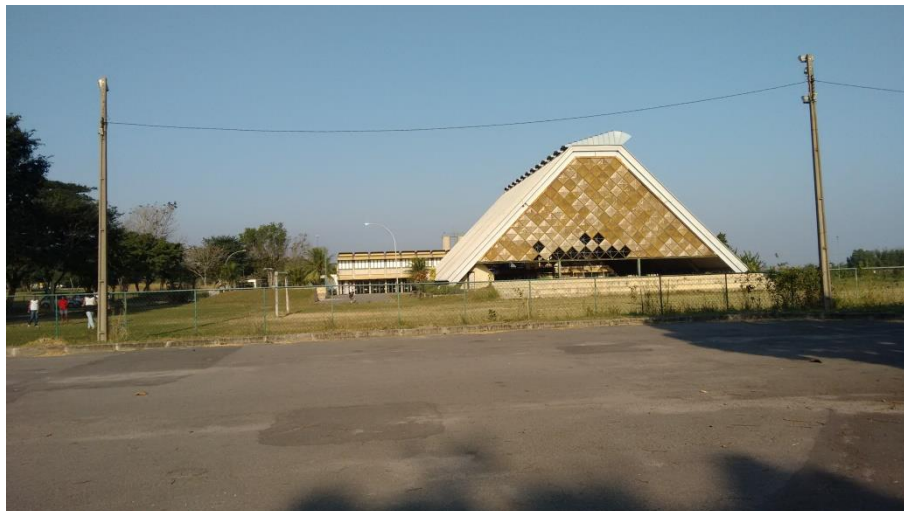
Figura I – CAIC visto pelo pátio do Instituto de Educação (IE) da UFRRJ
