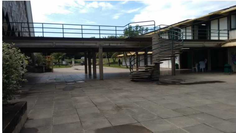
Figura VI – Acesso ao 2º pavimento da unidade escolar
