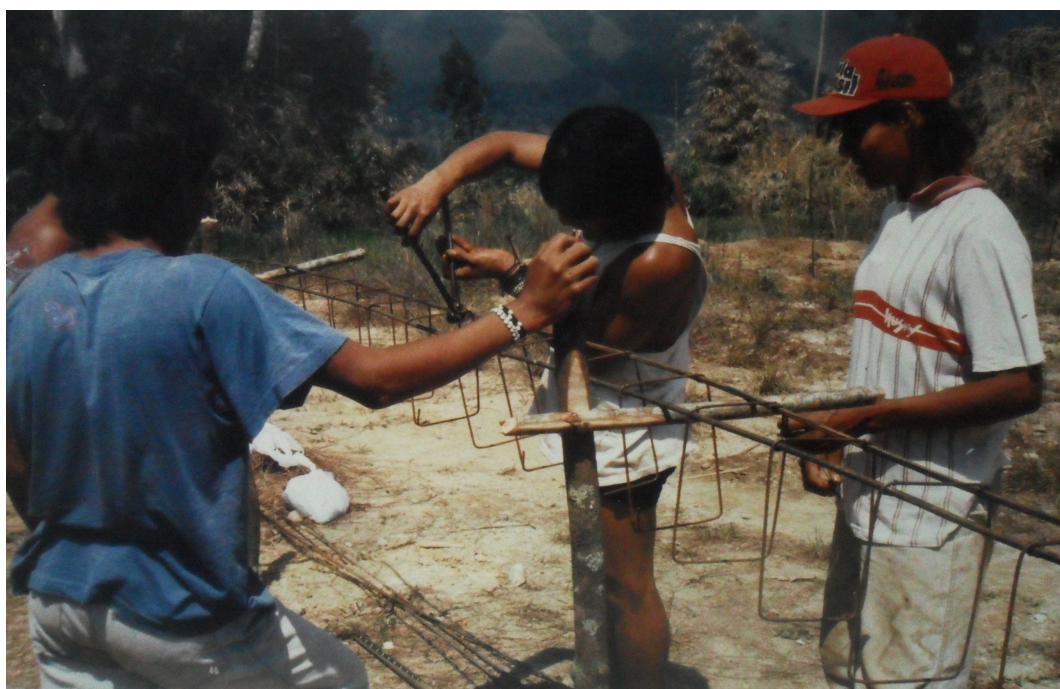
Figura 18: Jovens da aldeia confeccionando ferragens para a estrutura da obra.
