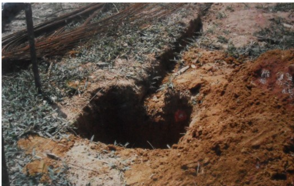
Figura 16: Buracos abertos para a fundação.
