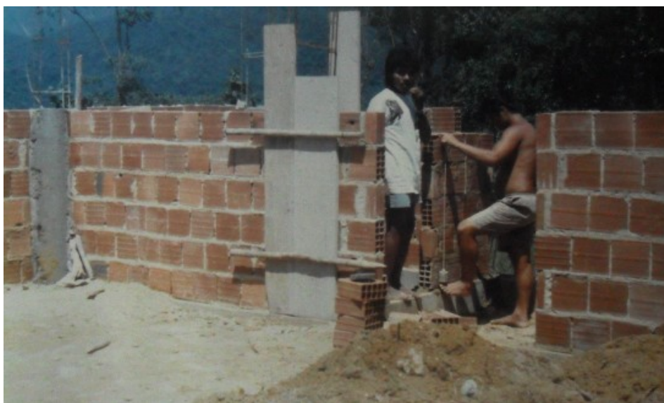
Figura 17: Sr. Valdemir, mestre de obras. Autor da planta e supervisor da obra.
