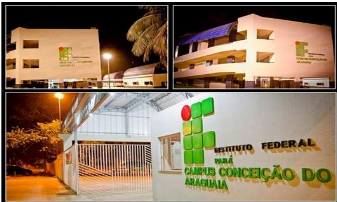
Figura 4 - Obra finalizada do IFPA - Campus Conceição do Araguaia – PA Foto – Divulgação/IFPA.
