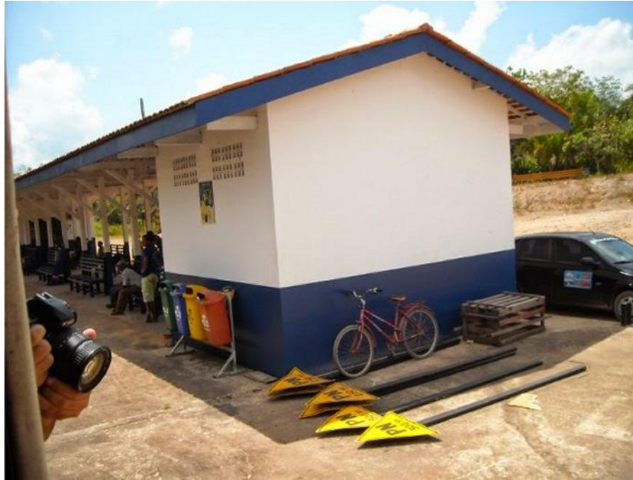
Figura 4: Estação Ferroviária do município de Porto Grande Fonte: http://www.estacoesferroviarias.com.br/amapa/santana.htm
