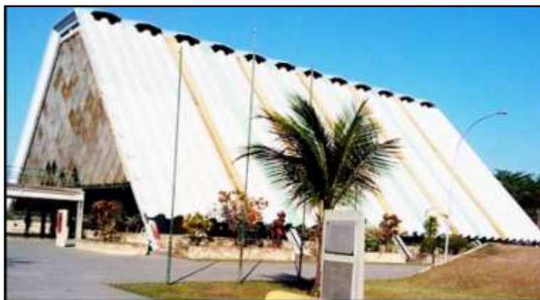
Figura 1- Vista parcial da quadra de esportes do CAIC
