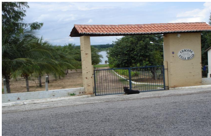
Figura 3 – Asfalto como infraestrutura para escoamento da produção. Estrada Petrolina-Tapera
