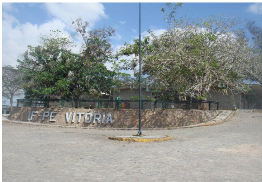
Figura 03: Prédio Principal do Campus Vitória de Santo Antão Fonte: Acervo da Pesquisadora – 2010
