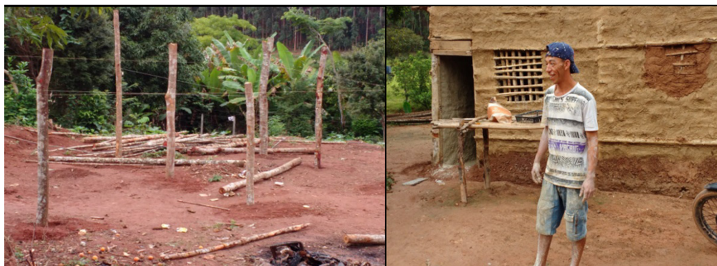
Figura 25 - Imagens de casa em construção na comunidade.
