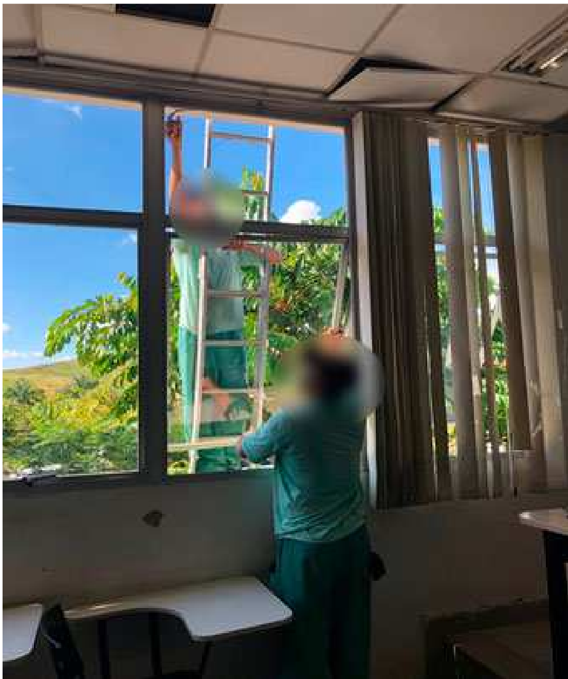
Figura 11: Reparos de Janelas Fonte: Elaborada pela Autora (2019)
