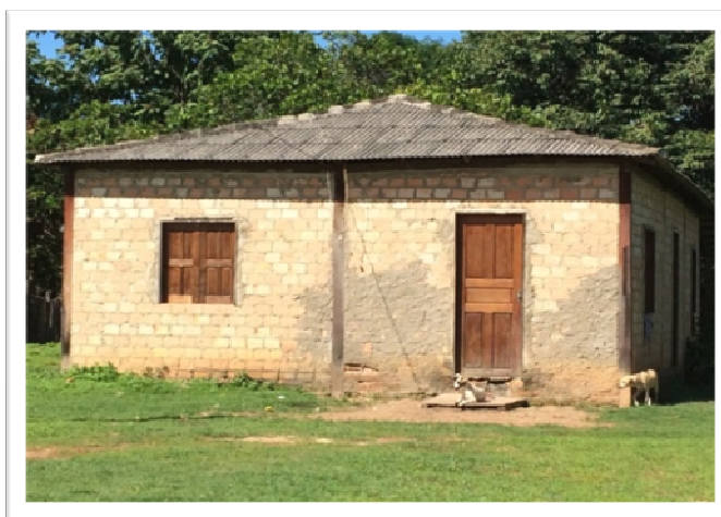
Figura 28 – Habitação construída com tijolos cerâmicos e cobertura de telhas de fibrocimento Fonte: a autora.
