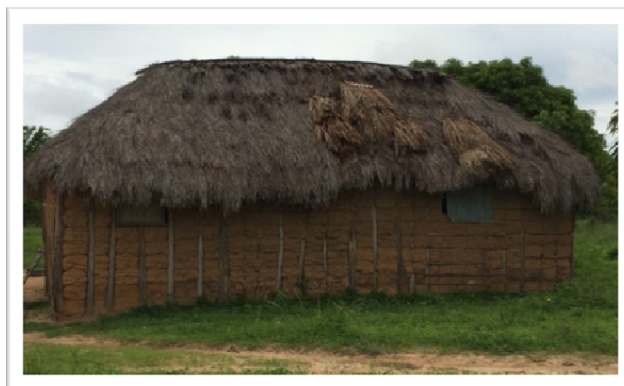
Figura 31 – Habitação de taipa coberta com palhas de buriti
