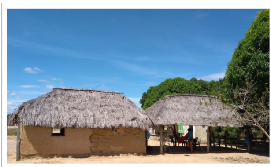
Figura 38 – Moradia com anexo
