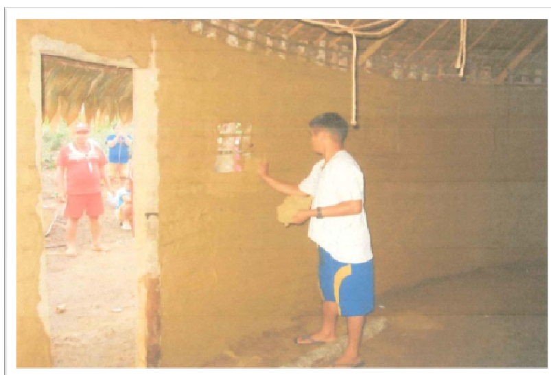
Figura 41 – Preenchimento de paredes de pau-a-pique. Etnia Ye'kuana
