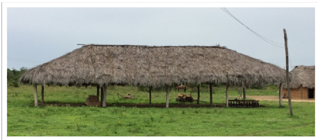
Figura 54 – Malocão com estrutura em estacas de madeira e coberto com palhas de buriti Fonte: a autora.
