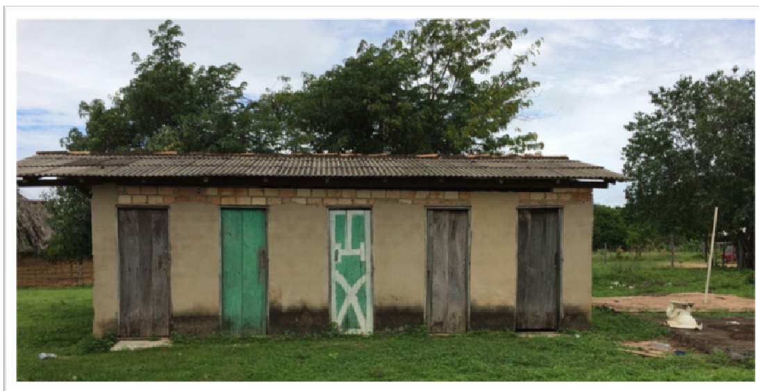
Figura 62 – Banheiros das casas de apoio
