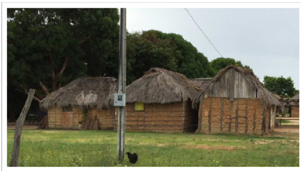
Figura 44 – Coberturas com palhas de buriti
