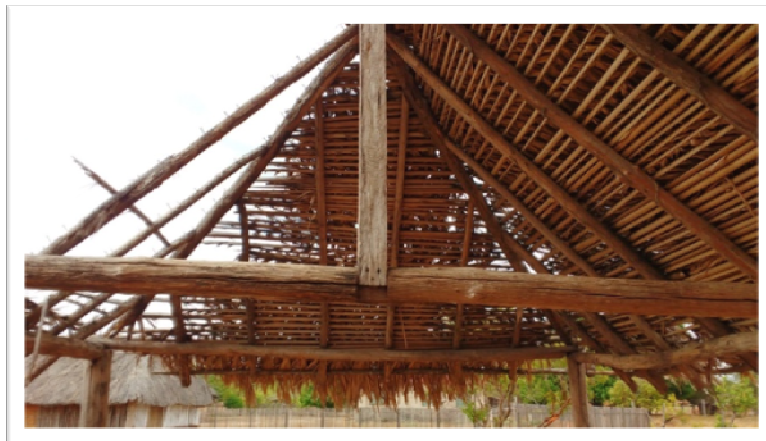
Figura 32 – Estrutura da cobertura
