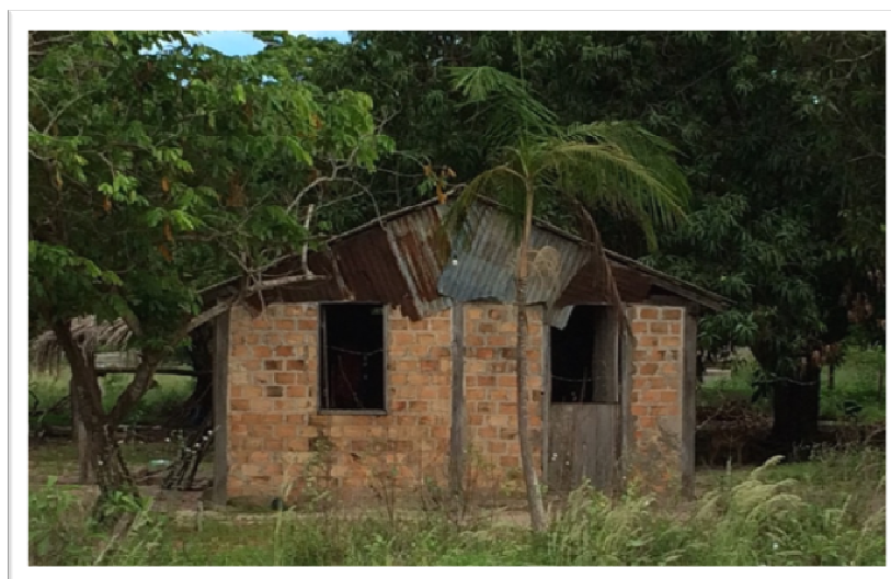
Figura 45 – Cobertura com aço zincado
