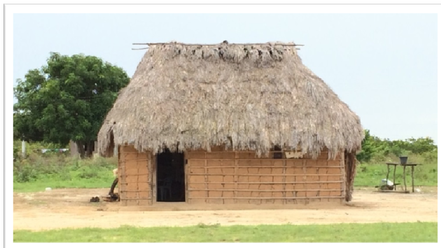
Figura 42 – Habitação de taipa e cobertura de palhas de buriti
