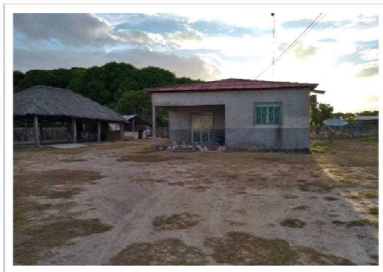
Figura 63 – Casa de alvenaria coberta com telhas de fibrocimento
