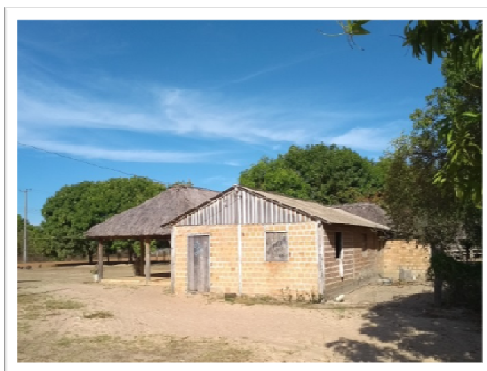
Figura 50 – Moradia em alvenaria e telhas de fibrocimento
