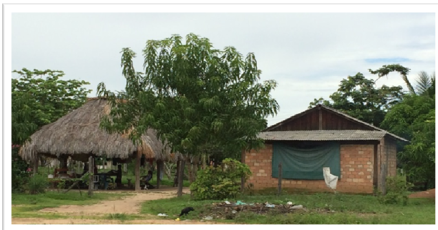
Figura 37 – Moradia com anexo
