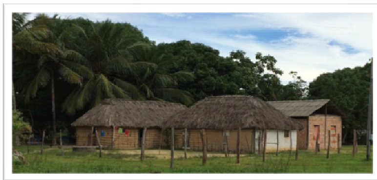
Figura 10 – Habitações com paredes de taipa cobertas com palhas de buriti/alvenaria de tijolos cerâmicos e telhas fibrocimento
