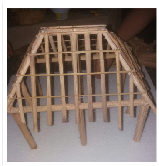
Figura 114 – A estrutura do telhado composta por caibros e ripas
