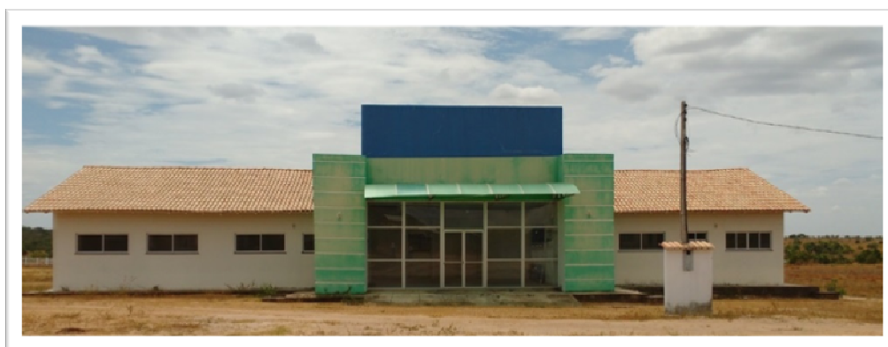
Figura 64 – Posto de Saúde construído em 2014
