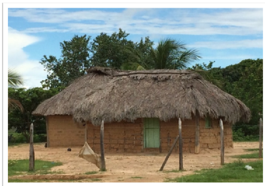
Figura 52 – Moradias construídas com paredes de taipa e tijolos de adobe Fonte: a autora.
