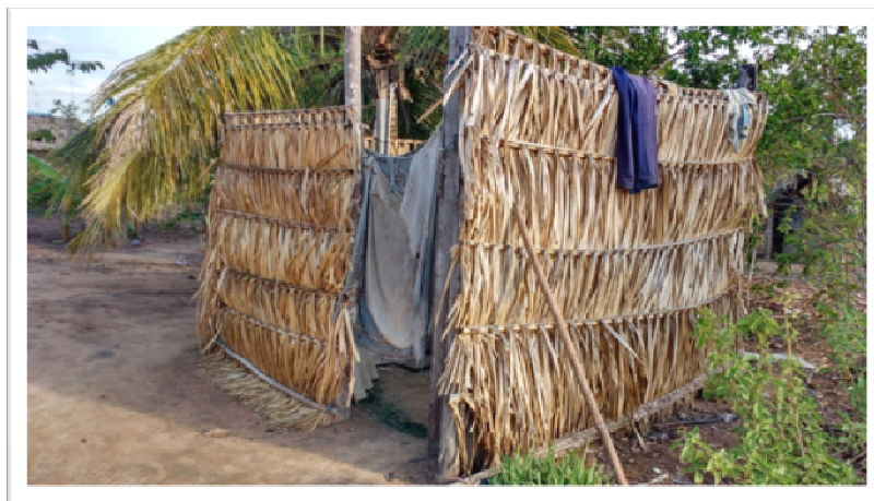
Figura 39 – Banheiro com vedação em palhas de inajá
