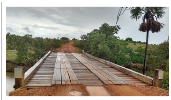
Figura 7 – Ponte sobre o Igarapé do Araçá
