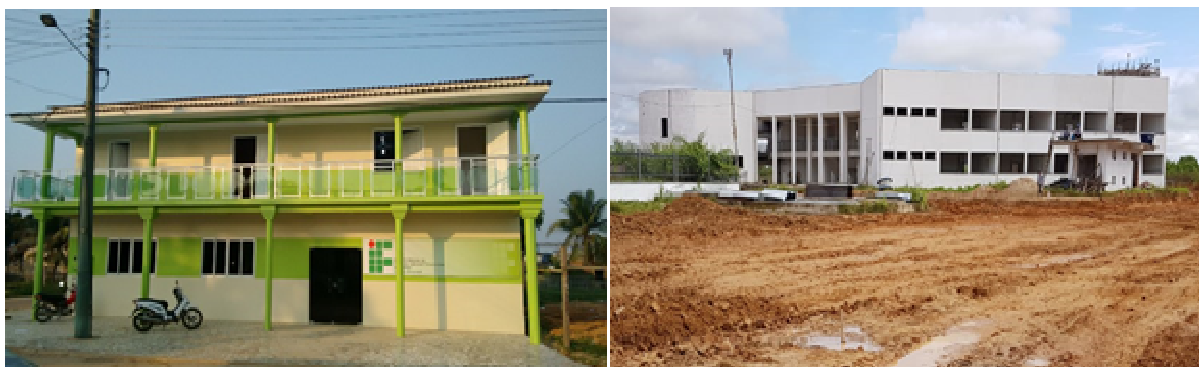
Figura 01: A esquerda prédio do IFAM Liceu (alugado), e a direita prédio do IFAM em construção.
