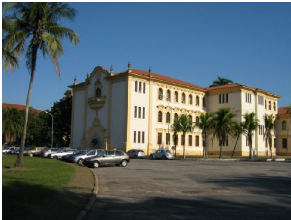
Figura 04 – Prédio nº. 1 (P1) da UFRRJ, onde funcionou o CTED, por alguns anos. (02/08/2007)
