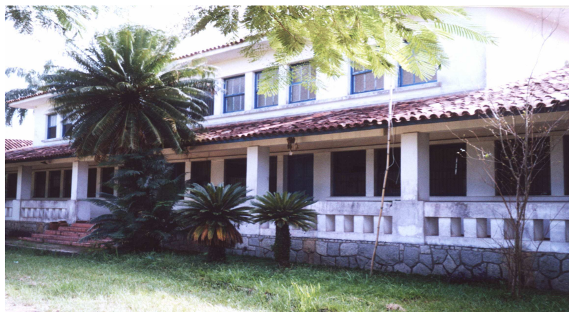
Figura 2 – Esta edificação abrigou o antigo Instituto de Meteorologia, e posteriormente foi sede do CTED, de 1966 a 1972, e do CTUR, de 1973 a 1988. Atualmente é o alojamento da Pós-Graduação da EMBRAPA.
