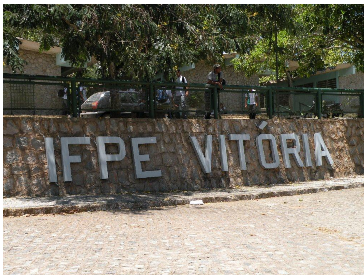
Figura 18. Fachada do IFPE Campus Vitória de Santo Antão
