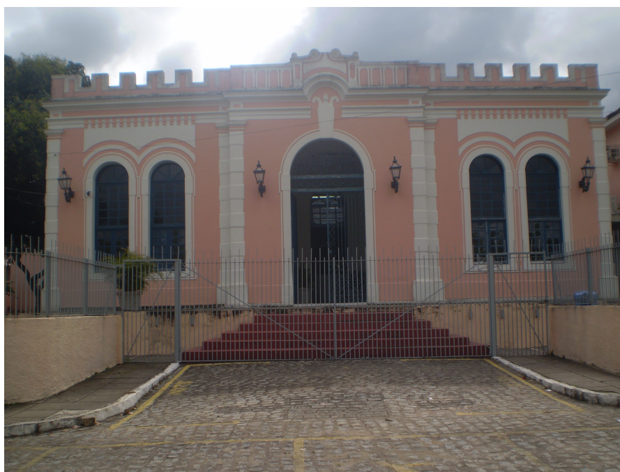
Figura 1 - Primeiro prédio da Escola Agrotécnica Federal de Vitória de Santo Antão/PE.
