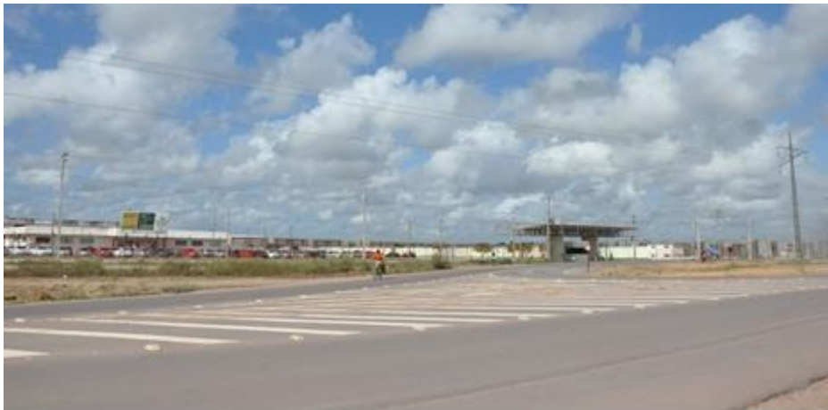
Figura 11 – Registro fotográfico da rodovia BR 210 em frente ao câmpus Macapá Fonte: Acervo da pesquisa (Conceição, Suely, Agosto 2014)
