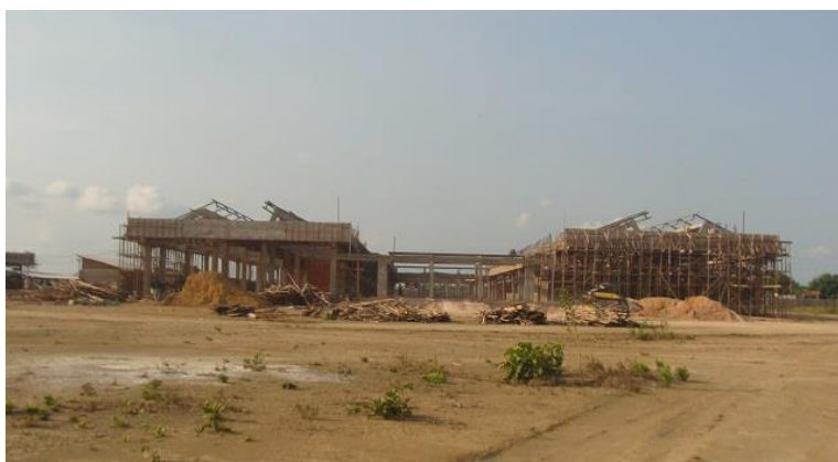
Figura 2 – Estado das obras de construção do câmpus Macapá em setembro de 2010 Fonte: Arquivo da ASCOM/IFAP, 2010
