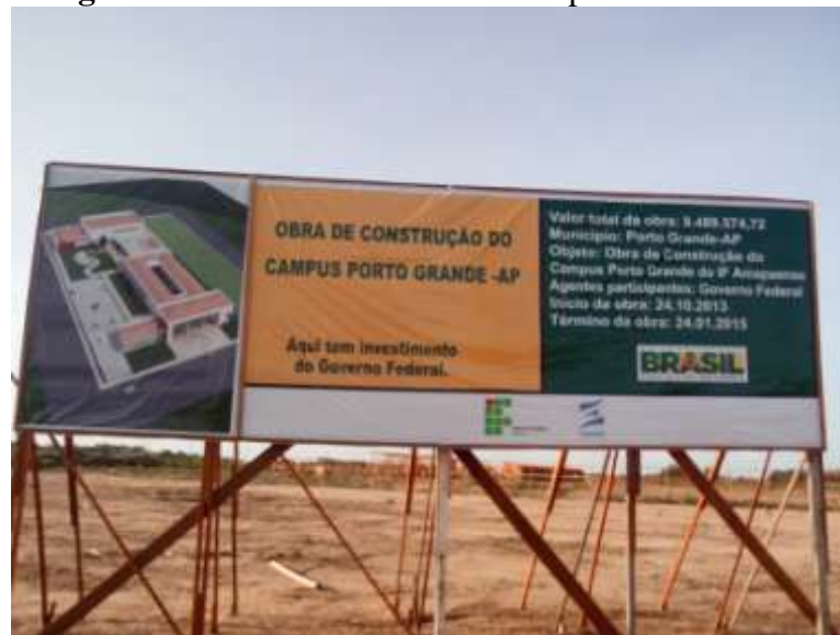
Figura 17 – Início das obras no Câmpus Porto Grande
