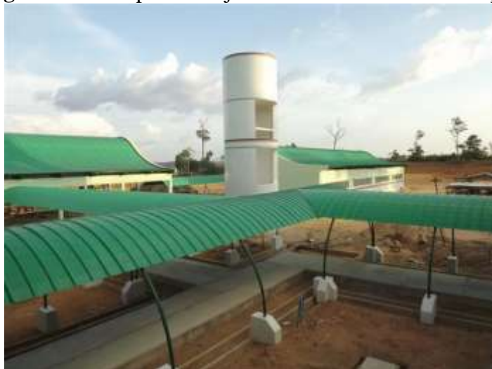
Figura 14 –Câmpus Laranjal do Jari em fase de construção
